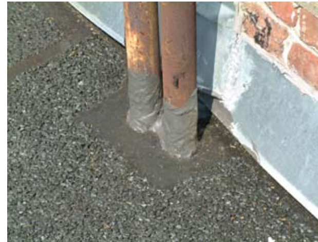
enkele details werden afgewerkt met polyesterhars
