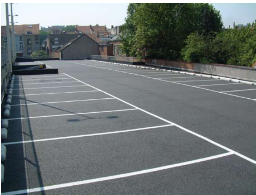
het afgewerkte dak
