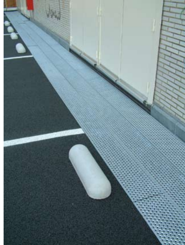
Langs de rand van het dak en de aanpalende gevels werden vrij brede goten voorzien om het afvoerwater voldoende te kunnen opvangen
