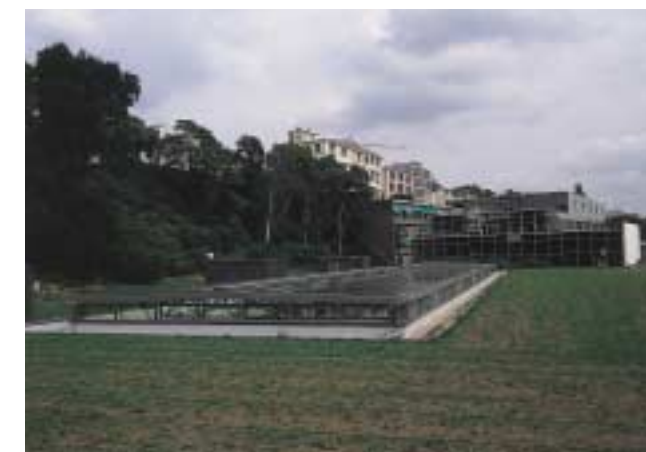
2 Buiten is de uitbreiding van de Hogeschool door de aanwezigheid van drie nooduitgangen, een installatiegebouwtje en het atriumdak duidelijk zichtbaar, maar de hoogte is zo gering dat het zicht op de stuwwal en het gebouw van Rietveld behouden is gebleven. Het glazen hoofdgebouw van Rietveld ligt aan de voet van een stuwwal, die de overgang markeert van de kleigrond van de Rijndelta naar de hoger gelegen zandgronden van de Veluwe.
