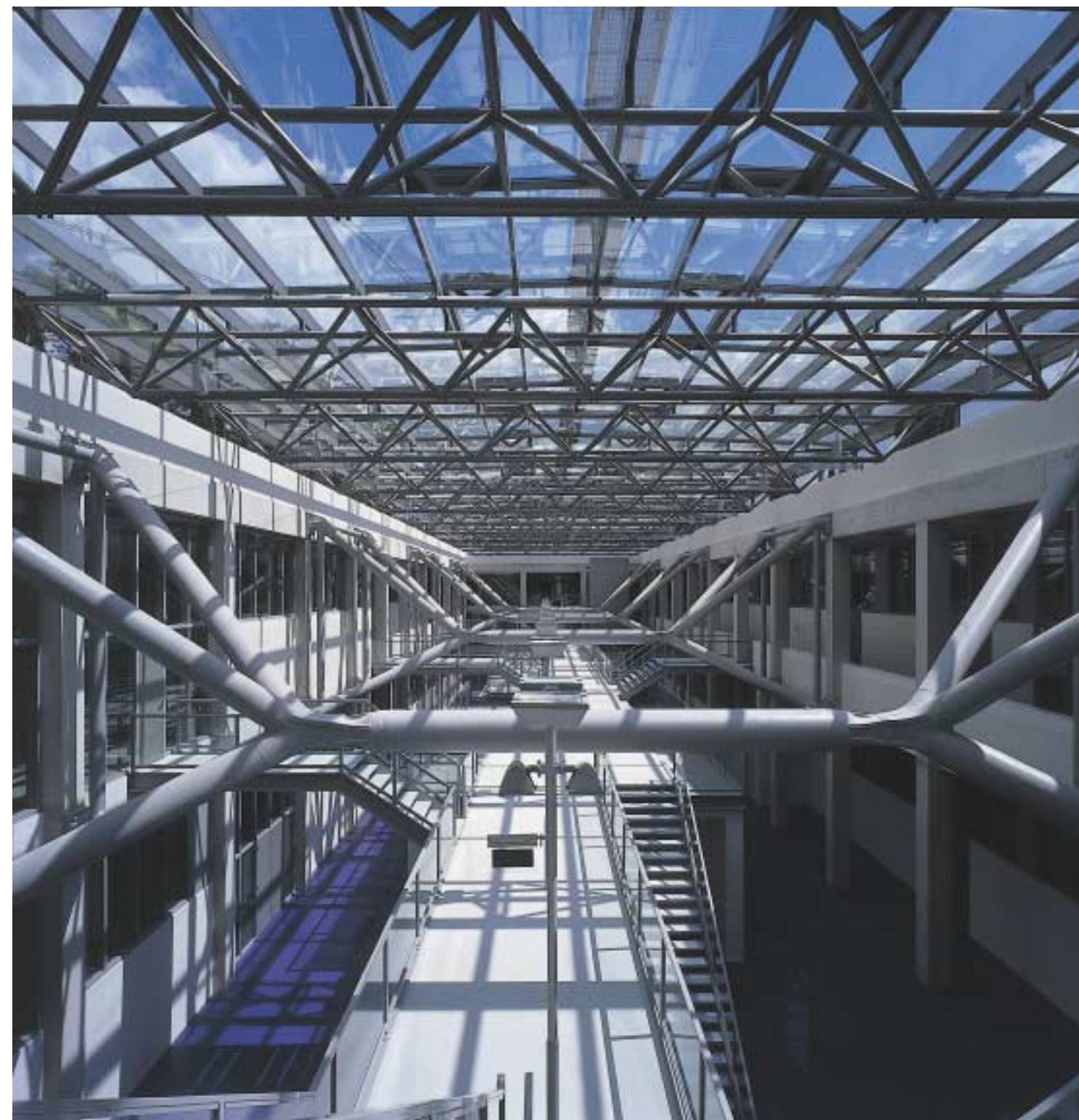
1 Het loopdek ligt halverwege twee vloerniveaus, zodat gebruikers hun hoofd niet stoten tegen de spanten. Trappen verbinden de verschillende vloeren met elkaar en overbruggen de verkeersruimtes op het laagste niveau.
