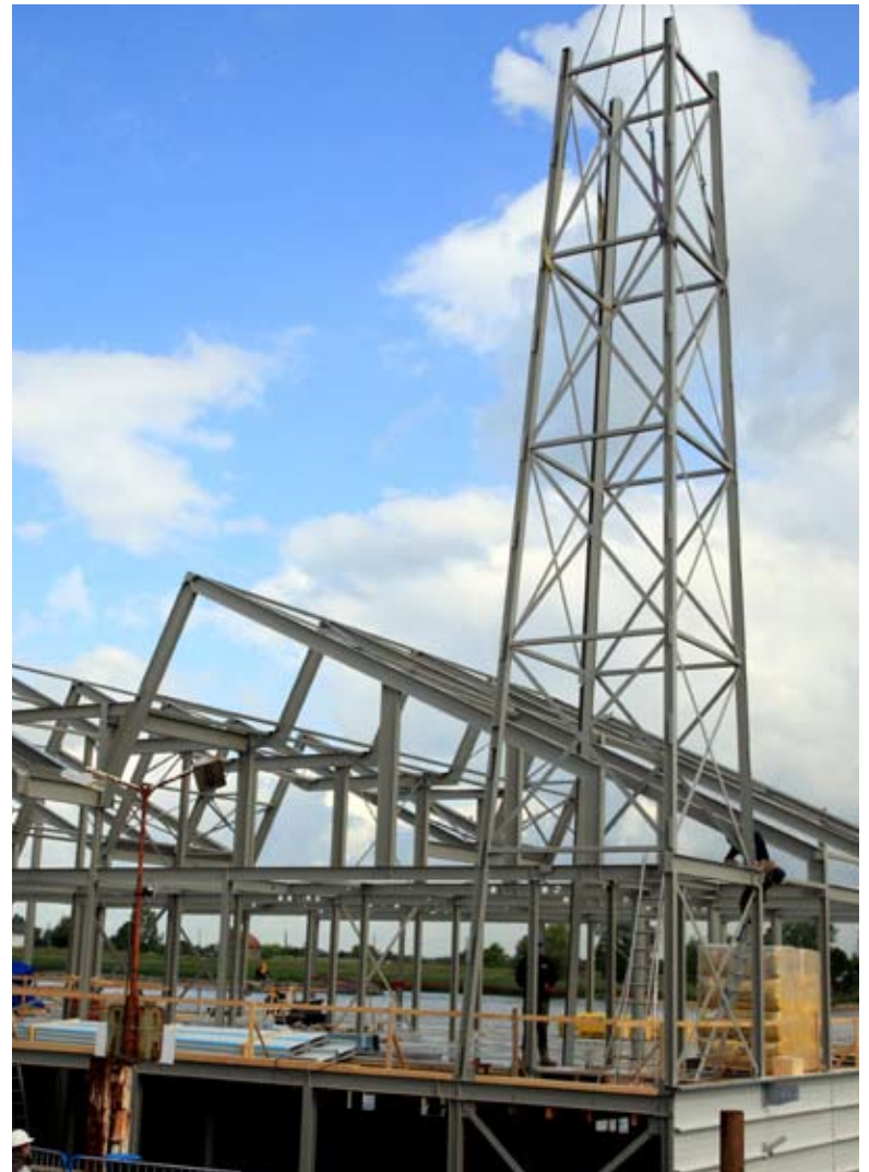
Bovenop het drijflichaam monteerde Buyk Constructies de stalen draagconstructie.
